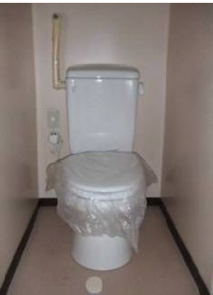
水循環式なので めんどろな洗浄水の 補給が軽減できます (雨水を利用した補給水タンク付)
